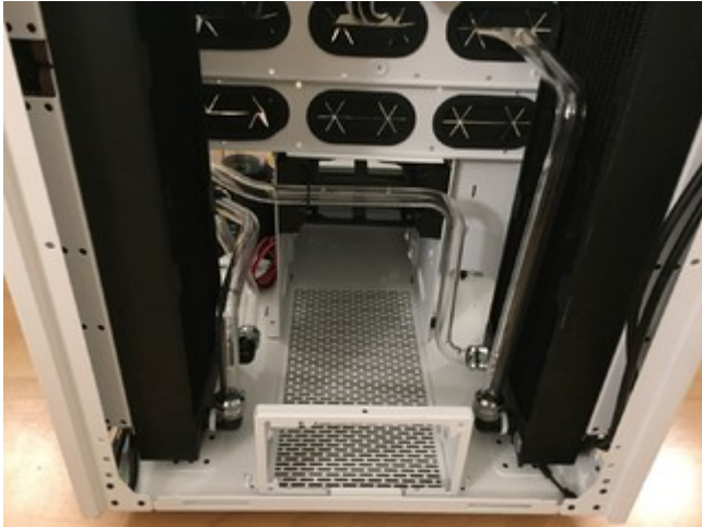
Ansicht von hinten:
